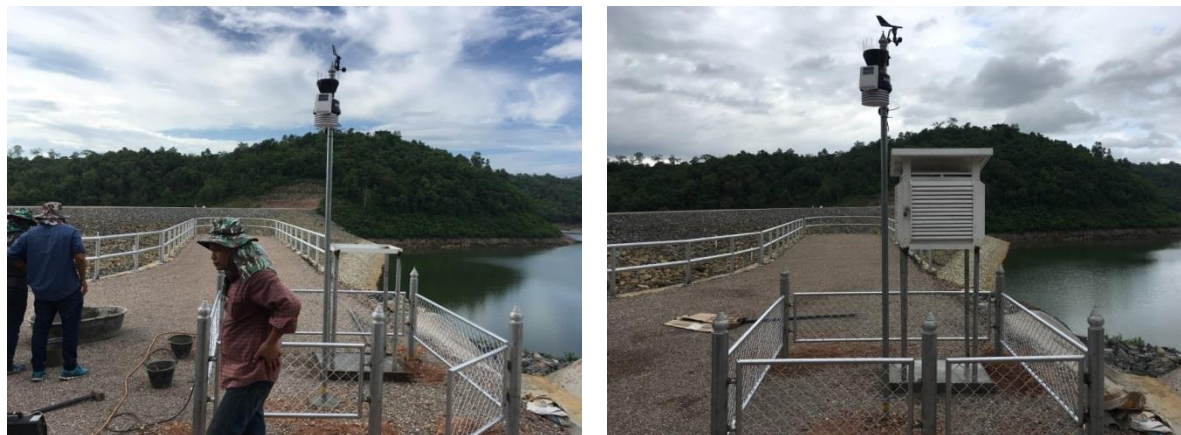
รูปที่ 5.2.1 - 2 การติดตั้งเครื่องวัดอุทกนิยมนิยามบริเวณหัวงานโครงการ
